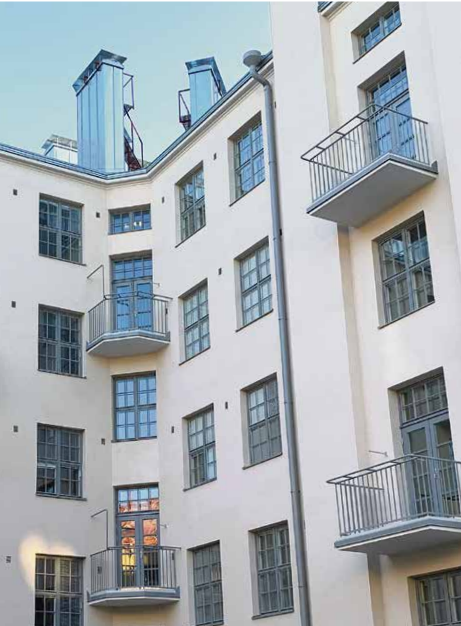
Helsinkiläisen Asunto Oy Euran julkisivuremontissa tehtiin erinomaisen hieno perinnejulkisivukorjaus, jossa onnistuttiin palauttamaan 1920-luvun arkkitehtuuri, ilme ja tunnelma vuosikymmenten jälkeen. Toteutus voitti Julkisivuremontti 2023 -kilpailun.
