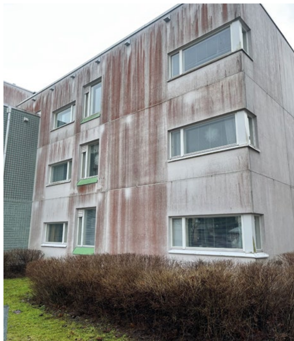
➡ Punajäkäläkasvuston tunnistaa tummanpunaisista pystyraidoista. Kuva: Suomen Julkisivupuhdistus
