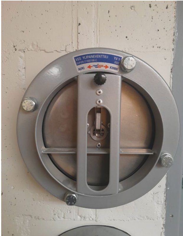
Ylipaine- ja padotusventtiilin avaaminen ja sulkeminen suositellaan tekemään vuosittain.
