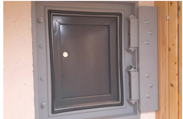
Väestönsuojan ovien ja luukkujen toimivuus ja tiiveys ovat tärkeitä.
