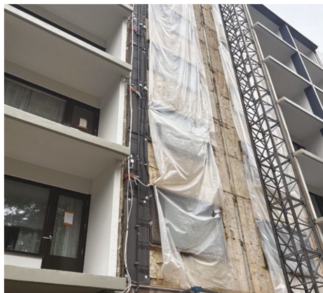
📍 Runosmäen hankkeessa 1970-luvulla rakennettuihin kerrostaloihin tehtiin samaan aikaan julkisivuremontti.
