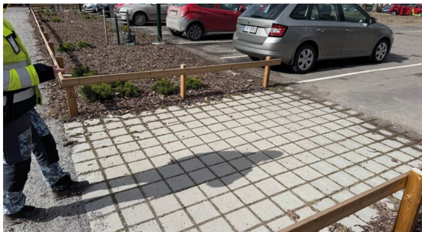
📍 Pinnat voidaan toteuttaa läpäisevinä, jolloin ne auttavat veden imeytymisessä ja vähentävät viemärikuormaa.
