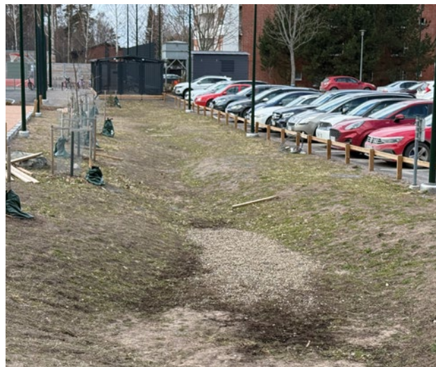
➊ Sadevedet ohjataan ensisijaisesti viheralueille kuten niityille, istutuksiin tai hulevesialtaisiin, joissa vesi voi suodattua, imeytyä ja viivästyä ennen kuin se ohjataan hulevesiverkostoon.
