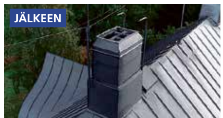
Peltikatto vuodelta 1926. Huoltomaalaus tehty 2020. Suositus huoltomaalaukselle 2045.
