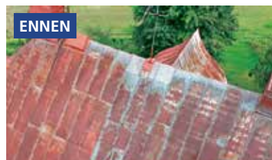
Peltikatto vuodelta 1926. Huoltomaalaus tehty 2020. Suositus huoltomaalaukselle 2045.
