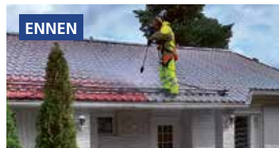
Ehjä teräspeltikate vuodelta 1995. Uusittu pinta 2020. Suositus huoltomaalaukselle 2045.
