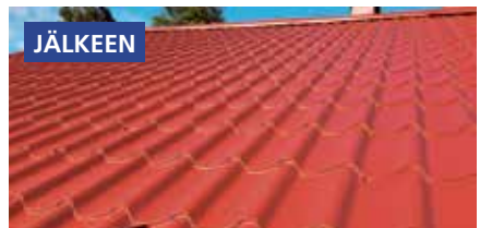
Ehjä teräspeltikate vuodelta 1995. Uusittu pinta 2020. Suositus huoltomaalaukselle 2045.
