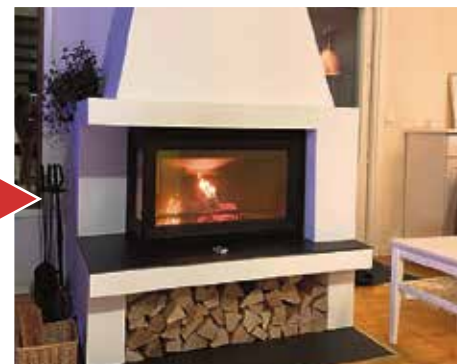
Avotakka takkasydämen asennuksen jälkeen
