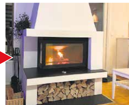
Avotakka takkasydämen asennuksen jälkeen
