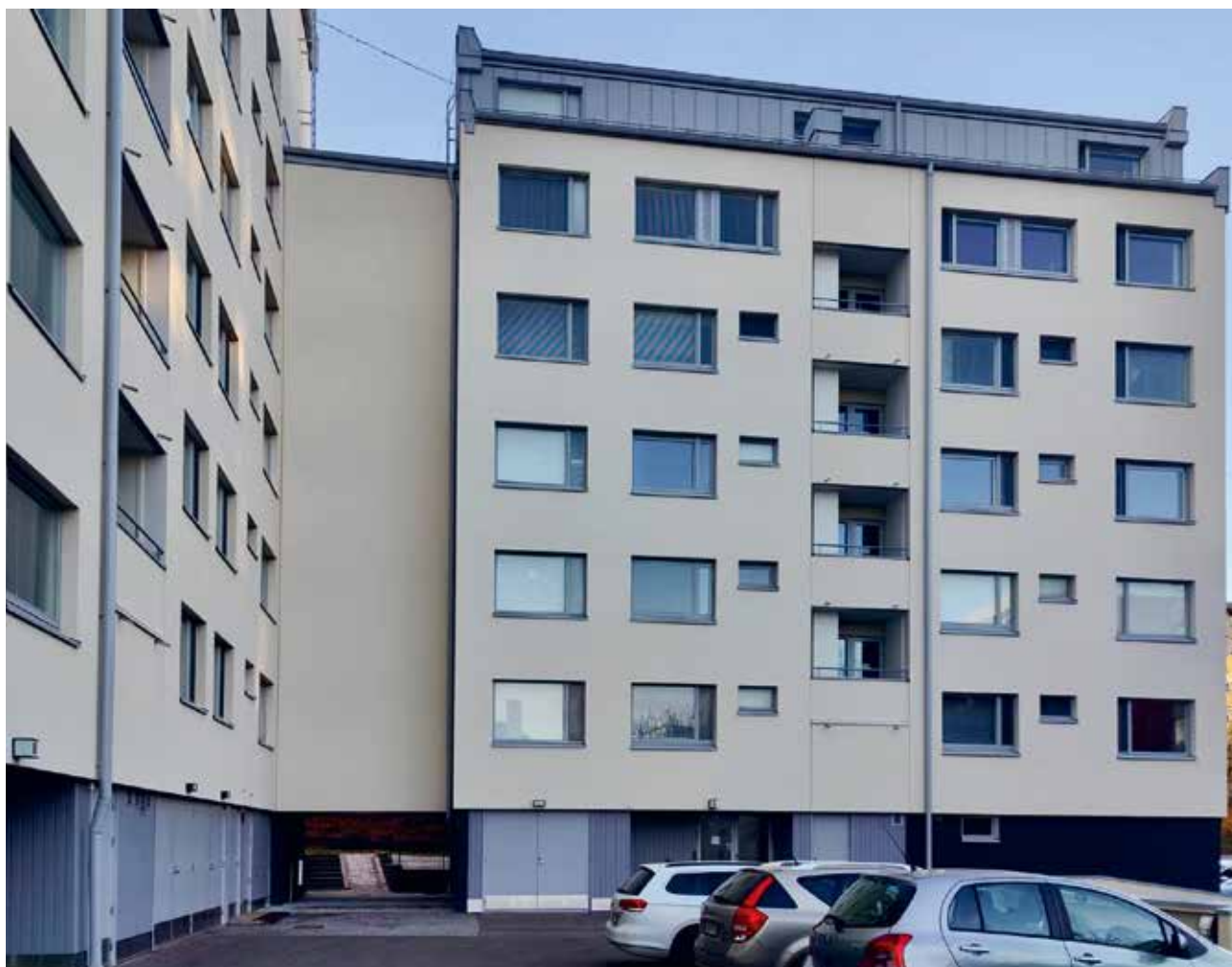
🔗 Kivenhakkaajankadun korjaushankkeessa saneerattiin julkisivu, uusittiin katto ja hankittiin lämmön talteenottojärjestelmä.
