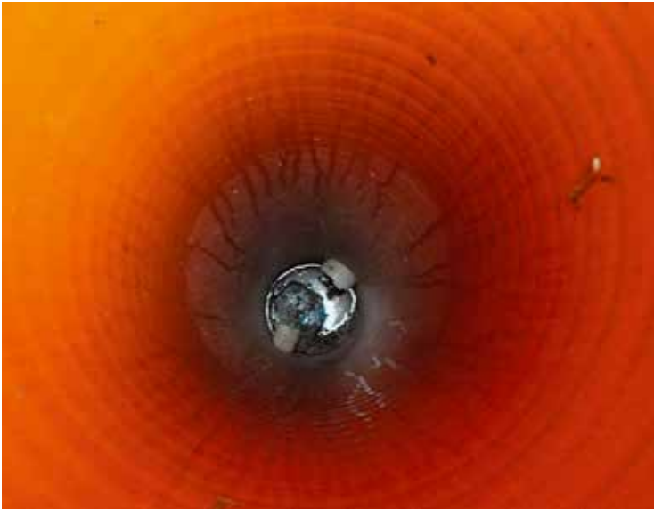
Tarkastuskaivon kautta voi mitata salaojien syvyyden ja selvittää sijaitsevatko ne kaikkialla rakennuksen perustamistason alapuolella, kuten suositus on.
