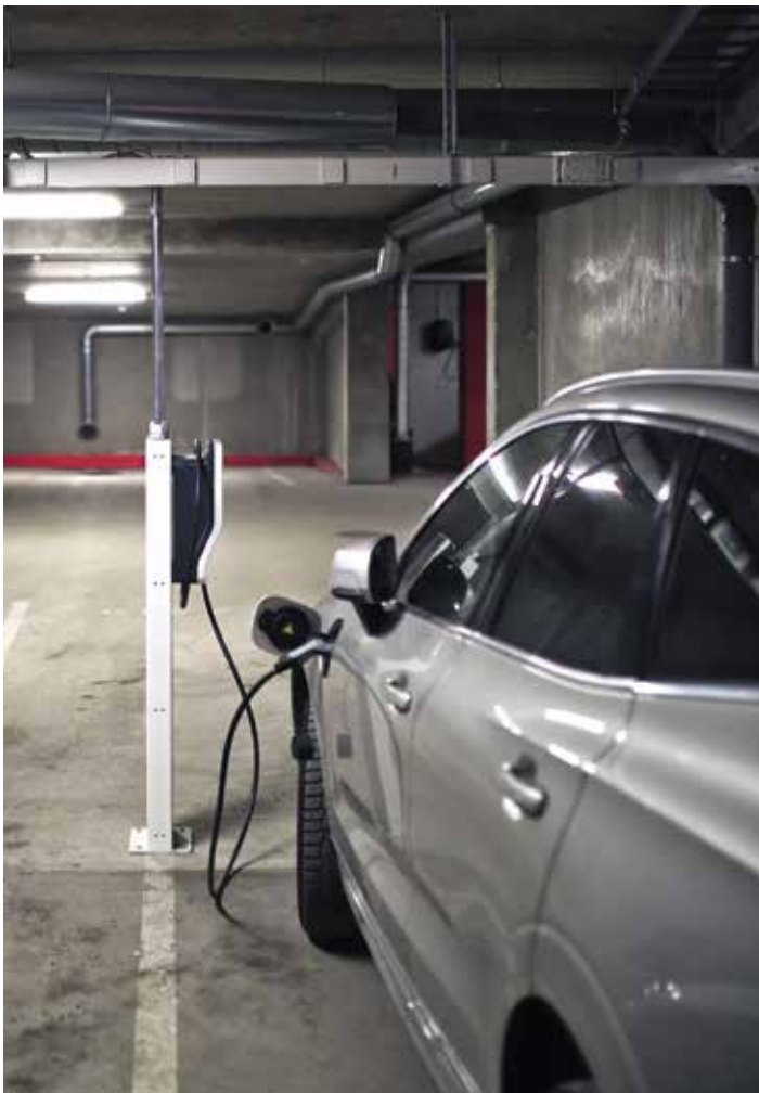
⬆ Hallin katossa kulkee autopaikoille sähkön jakava virtakisko, johon on liitetty autopaikan virranotin.
