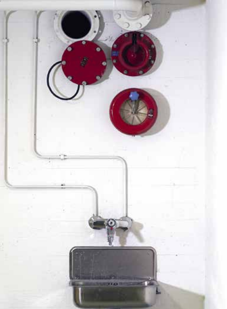
➊ Ylipaineventtiilit ja vesipisteet ovat keskeinen osa väestönsuojan laitteistoa.
