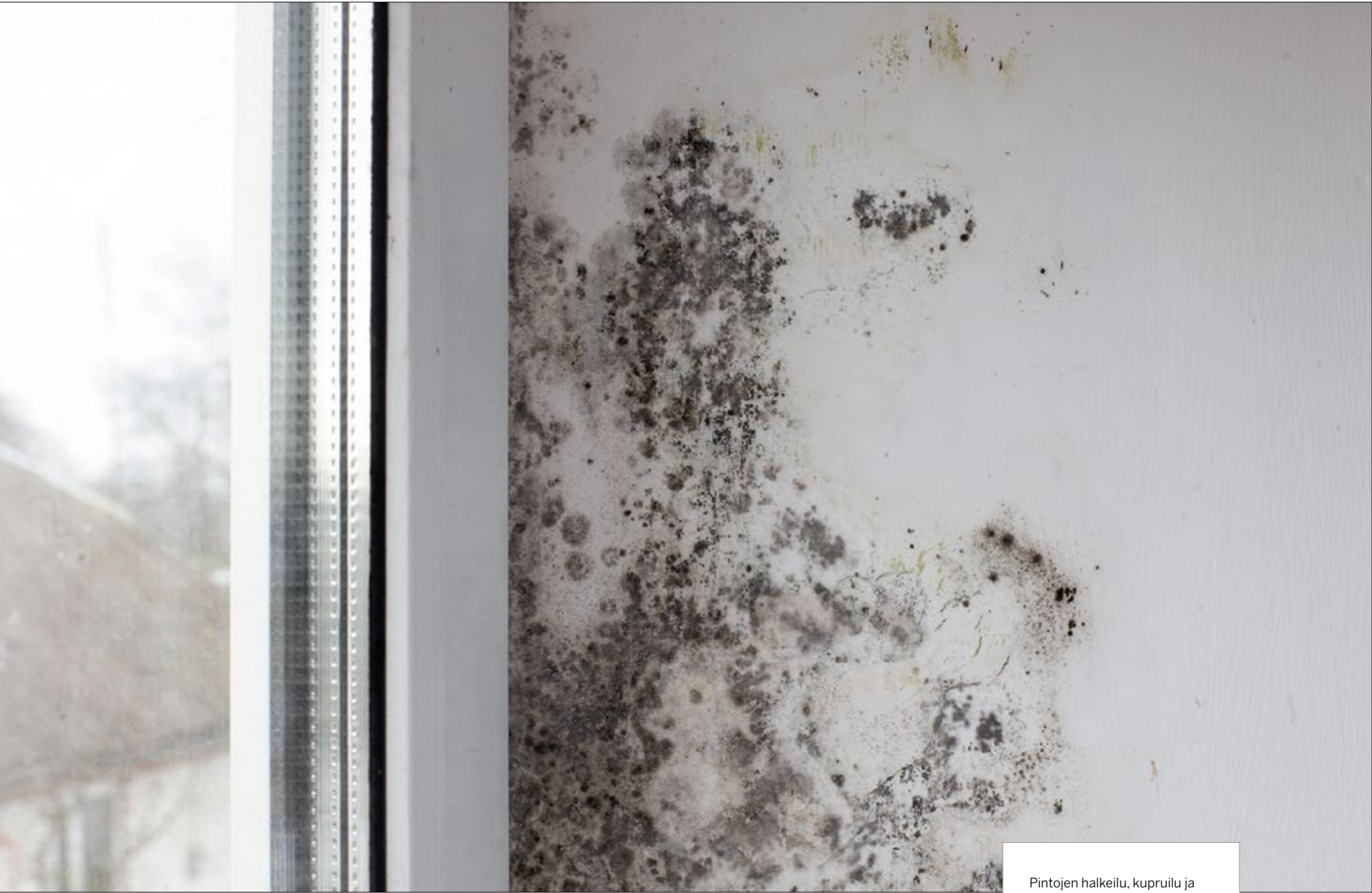
Pintojen halkeilu, kupruilu ja värimuutokset ovat merkkejä rakenteisiin pesiytyneestä kosteudesta.
