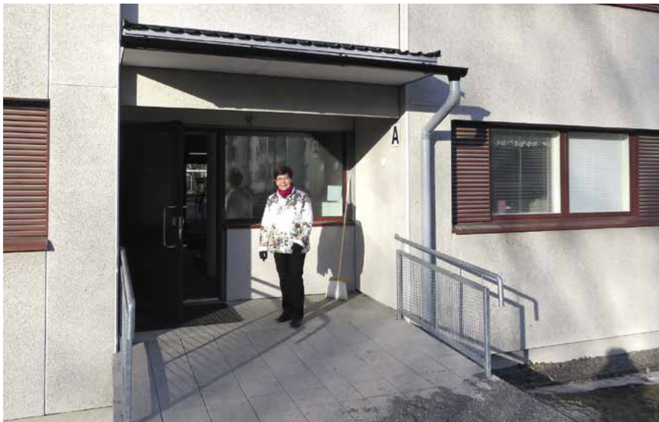
➊ Uusien sisäänkäyntien yhteyteen tehtiin pienet katokset ja luiskan pinta on laatoitettu betonilaatalla, joka ei ole liukas märkänäköön, kertoo Kristiina Hellstén.
