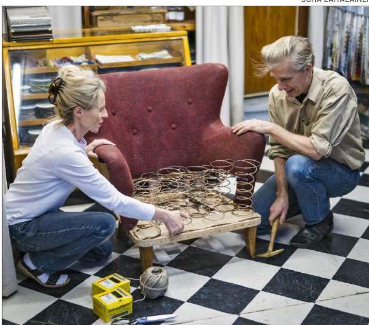
Verhoilija-artistit Mia Rantala ja verhoilijamestari Ari Toivonen sovittavat jousia Ilmari Lappalaisen suunnittelemaan Laila-nojatuoliin. Perinteisten joustinhuonekalujen korjaamisessa on monta työvaihetta, jotka kaikki pitää tehdä käsin.
