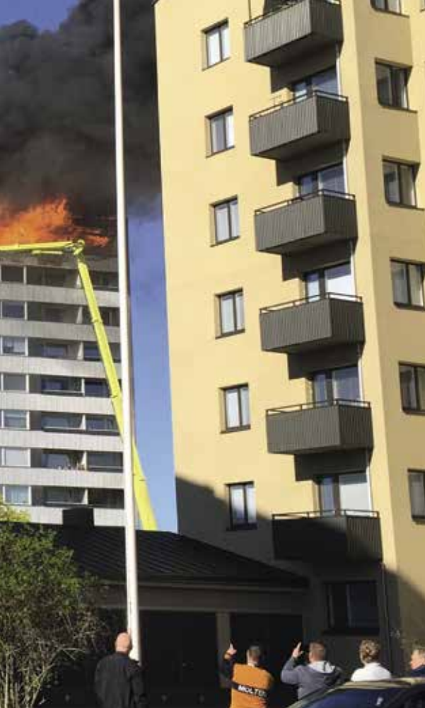
⬆ Keskuskartanon palo alkoi talon 11. kerroksesta E-portaan kohdalta. Loppujen lopuksi talon koko 11. kerros ja vesikatto tuhoutuivat niin, että se rakennetaan käytännössä uudestaan.
