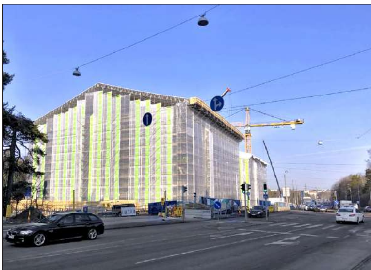
Tammisairaala rakennetaan muuntojoustavaksi ja pitkäikäiseksi. Betoni- ja teräsrunkoisen sairaalarakennuksen tilat muuntautuvat myös muiden kuin silmäpotilaiden hoitoon.
