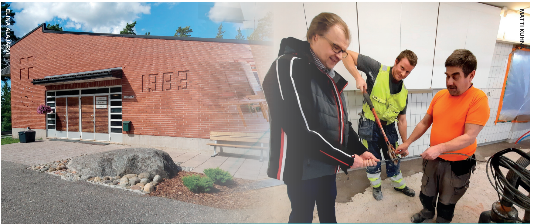
Vääntöä riittää Silokallion keittiöremontissa, toteavat kiinteistöpäällikkö Arto Huhtanen sekä kirvesmies Kalle Anttila ja työnjohtaja Harri Nieminen Niepar Oy:ltä.
