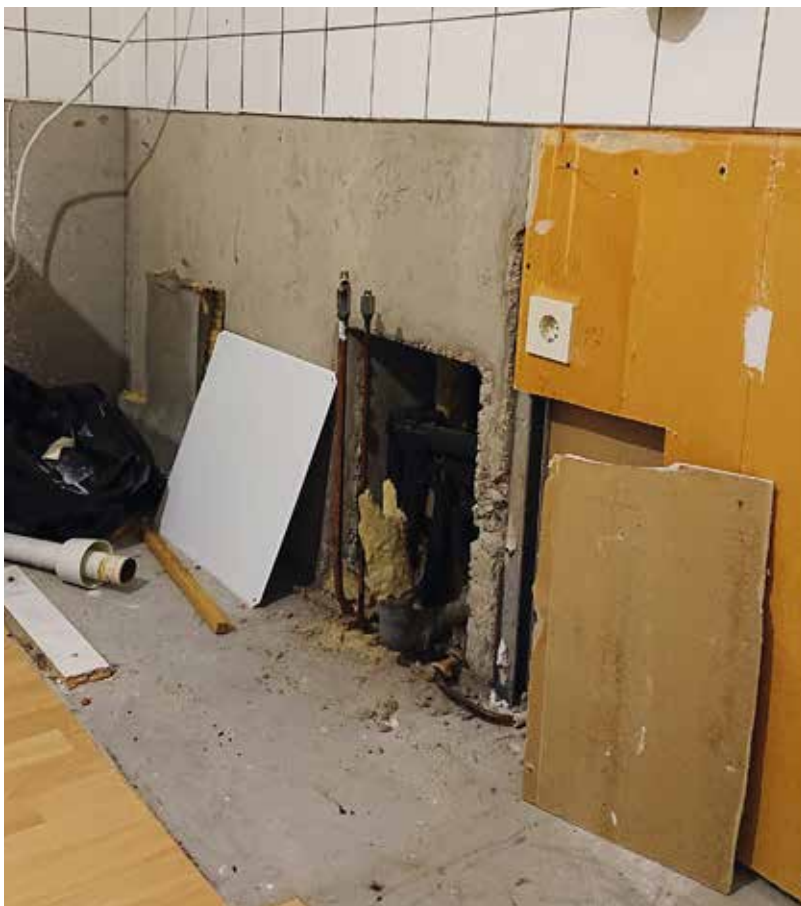
Piilevä putkivuoto huoneiston keittiössä paljastui vasta sitten, kun vettä oli jo vuotanut taloyhtiön katutasossa sijaitsevaan kerhohuoneeseen litraukapalla.
