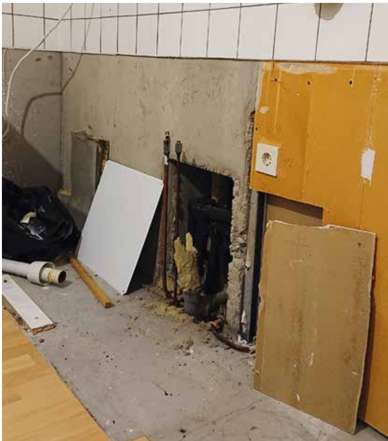
Piilevä putkivuoto huoneiston keittiössä paljastui vasta sitten, kun vettä oli jo vuotanut taloyhtiön katutasossa sijaitsevaan kerhohuoneeseen litrakaupalla.
