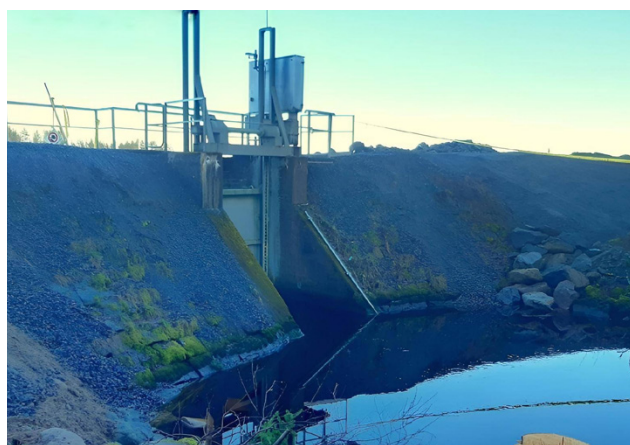
Kätkänjärven säännöstelypato. Säännöstelypadon molemmat puolet olevat maapadot kunnostettiin vuonna 2020. Kuva: Etelä-Pohjanmaan ELY-keskus.
