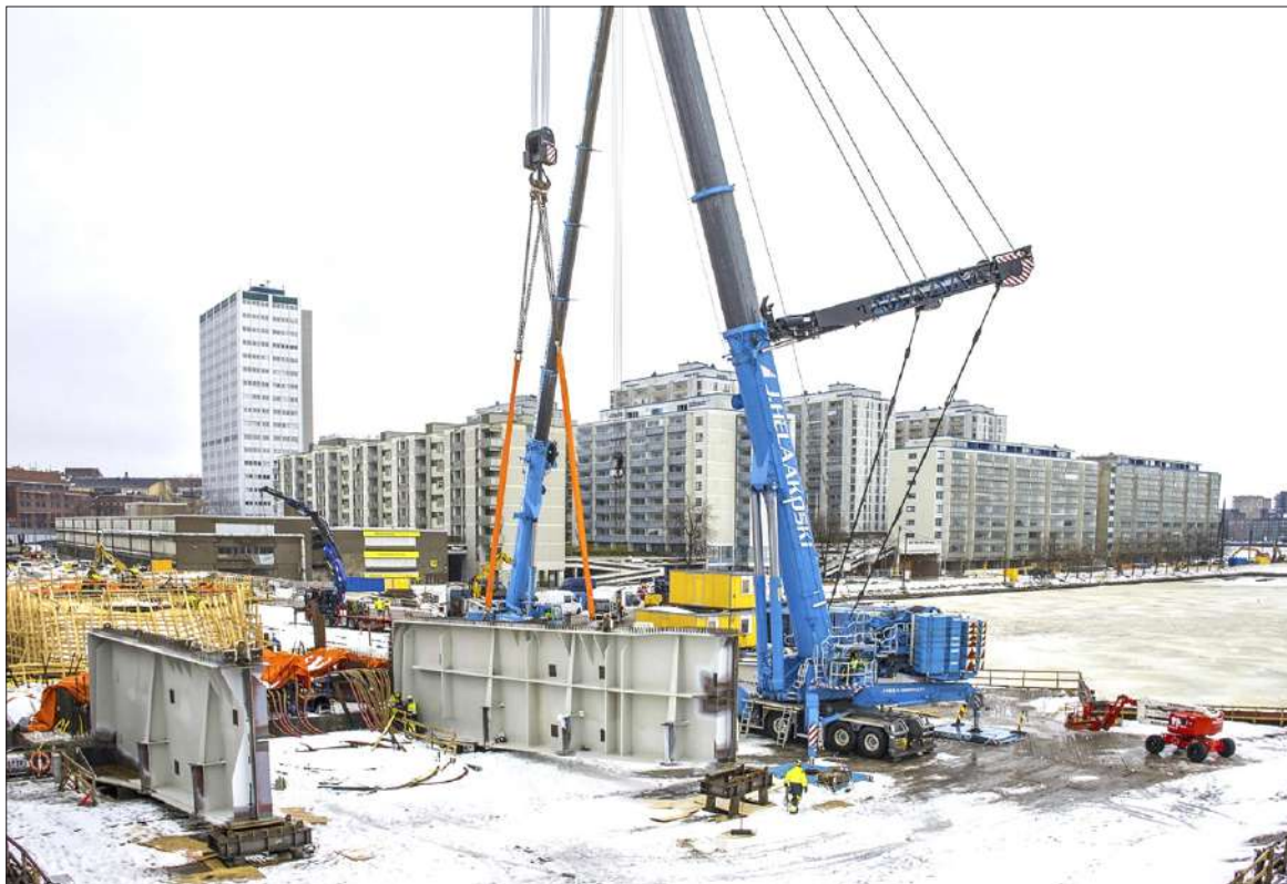
Ensimmäinen teräsosa (vas.) saatiin nostettua paikalleen jo tiistaina 10.1. Tuulen yltyneen vuoksi toinen palkki nostettiin vasta seuraavana päivänä.
