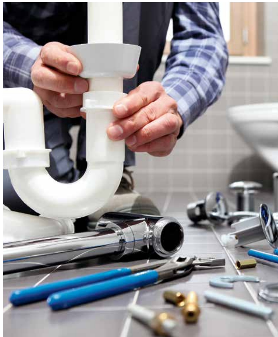
Vesi- ja viemäriputkistot ovat yksi tavallisimmista kuntotutkimuksen kohteista taloyhtiössä.
