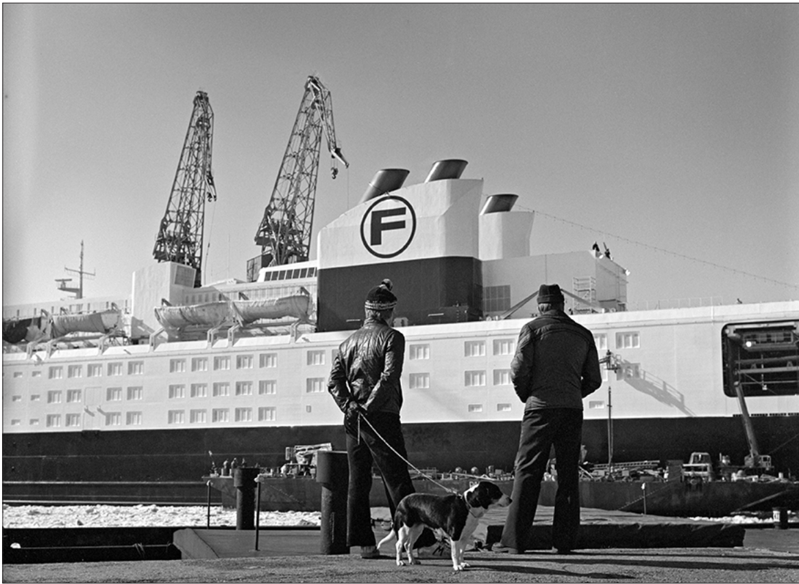
Matkustaja-autolautta GTS Finnjet rakenteilla Hietalahden telakalla vuonna 1977. Telakalla suunniteltu ja rakennettu Finnjet oli maailman ensimmäinen kaasuturbiinikäyttöinen matkustajalaiva. Jussi-Pekka Lämsä seuraa kirjatrilogiassaan myös Finnjetin matkaa sen valmistumisesta aina romuttamiseen.
