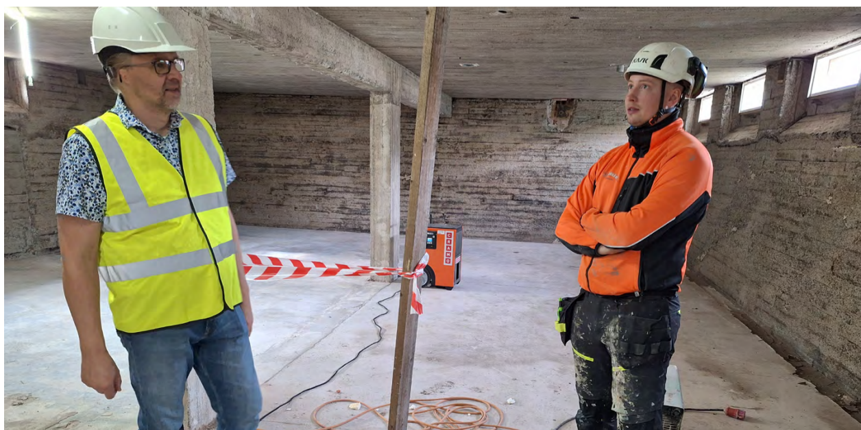
Kiinteistöpäällikkö Arto Huhtanen (vas.) ja vastaava mestari Jari-Petteri Joutsenlahti tutkailemassa Länsi-Porin kirkon purettuja kellaritiloja. Purku- ja rakennustöitä on alusta alkaen päästy tekemään limittäin.
