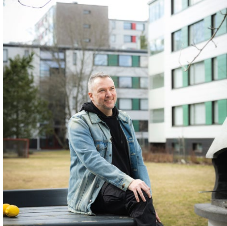
As Oy Varkkapelto oli osana Suomen suurinta saneerausprojektia vuosina 2021–23. Mittavassa uudistuksessa taloihin tehtiin julkisivuremontti, linjasaneeraus ja maanrakennusurakka.
