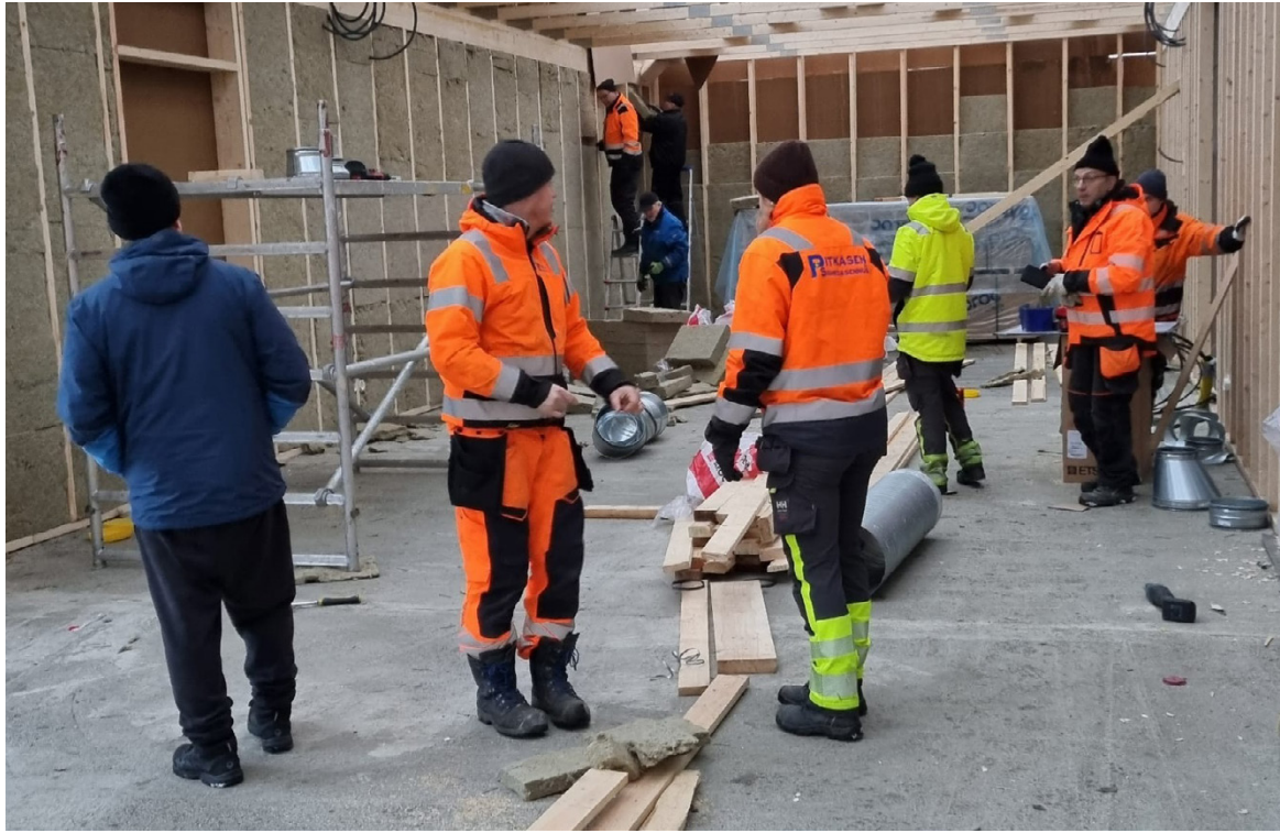
Talkoolaiset työn touhussa laajennusta rakentamassa. Kuva: Hilikka Luoma-aho.
