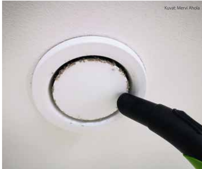
Poistoventtiilin imurointi.
