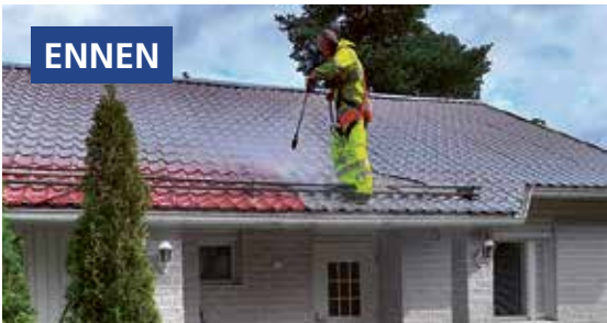
Ehjä teräspeltikate vuodelta 1995. Uusittu pinta 2020. Suositus huoltomaalaukselle 2070.
