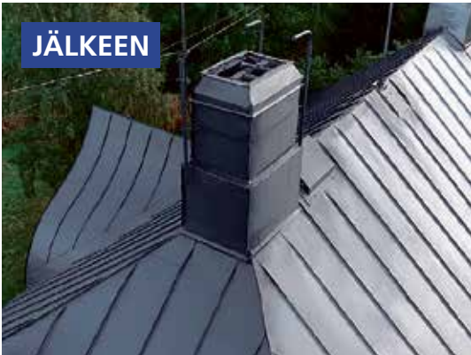
Peltikatto vuodelta 1926. Huoltomaalaus tehty 2020. Suositus huoltomaalaukselle 2060.
