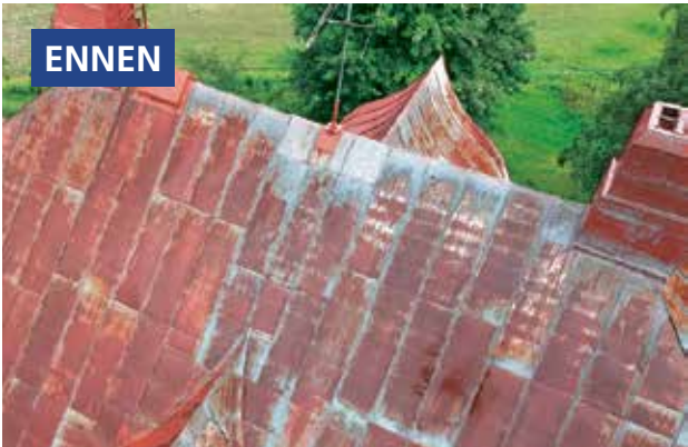
Peltikatto vuodelta 1926. Huoltomaalaus tehty 2020. Suositus huoltomaalaukselle 2060.
