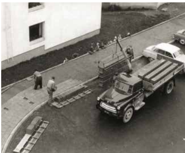
↑ Jalkakäytävän rakentamista Iso-Heikkilänmäessä. Katualueiden ja kunnallistekniikan rakentaminen oli iso kustannuserä Turun kaupungille.
