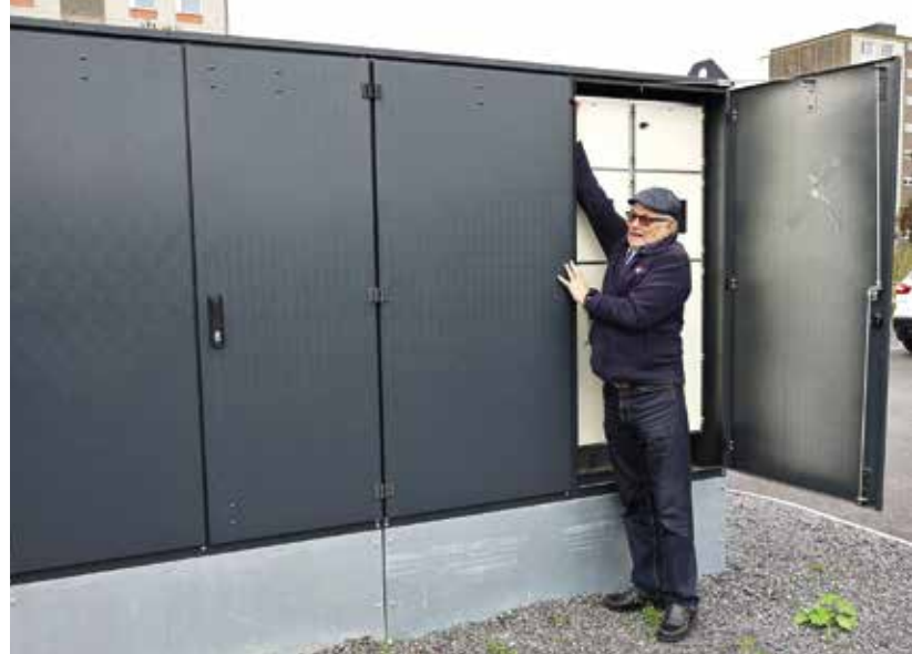
📍 Sampolaan valmistui alkuvuonna Porin suurin sähköautojen latausvalmiudessa varustettu pysäköintialue. Altti Aronen esittelee sähköjakokeskusta, jota kautta sähkö siirtyy muuntajasta autopaikoille.
