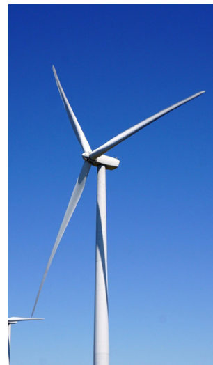
Tuulipuistohankkeen rakennustyöt Soinin Korkeamaalla etenevät aikataulun mukaisesti ja useita keskeisiä työvaiheita on saatu käyntiin.
