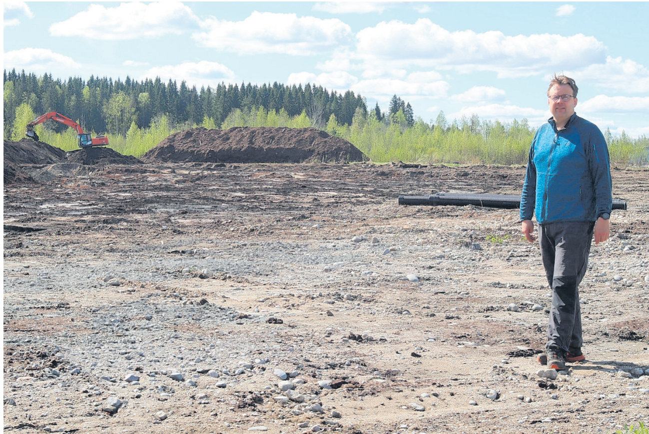
EJ-Tarhojen toimitusjohtaja Esa Järvelä uuden viljely-yksikön rakennusalueella Soinin teollisuusalueella. Alueelle rakentuu vaihteittain uudenlainen kasvihuonekokonaisuus, jonka kaltaista ei ole aiemmin toteutettu Suomessa.
