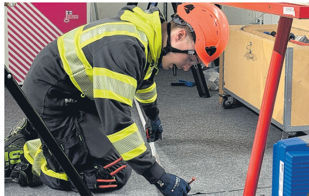
Putkiasennuksen tuore SM-mitalisti opiskelee toista vuotta talotekniikan perustutkintoa Sedun Lapuan kampuksella.
