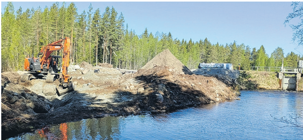
Kätkänjärven säännöstelypadon kunnostusurakka on alkanut ohitusuoman kaivamisella.
