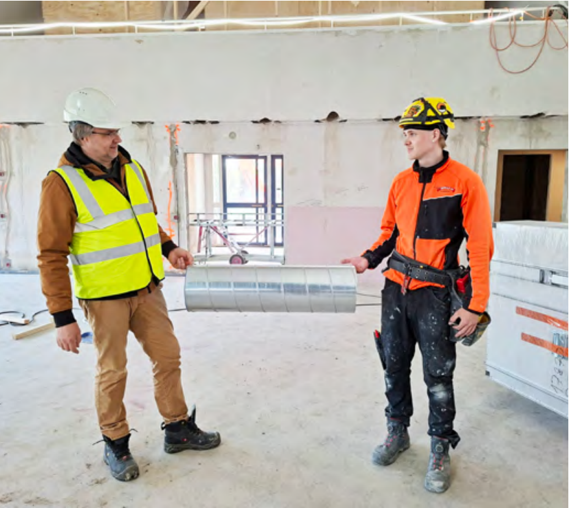
Vielä riittää tekemistä. Kiinteistöpäällikkö Arto Huhtanen ja pääurakoitsija Veljekset Mäkilä Oy:n rakennusmies Juhon Helin mittailemassa kirkon rakenteisiin asennettavaa ilmanvaihtoputken patkkaa. Taustalla kirkon pääuloskäynti.
