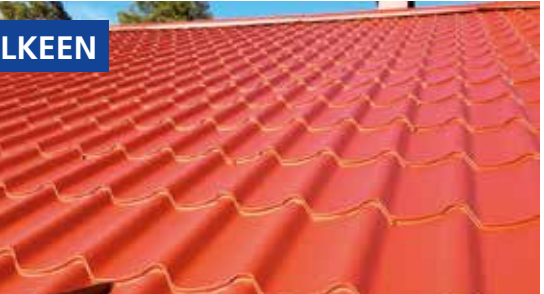
ENNEN Ehjä teräspeltikate vuodelta 1995. Uusittu pinta 2020. Suositus huoltomaalaukselle 2060.
