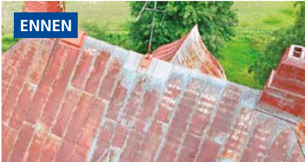
ENNEN Peltikatto vuodelta 1926. Huoltomaalaus tehty 2020. Suositus huoltomaalaukselle 2060.
