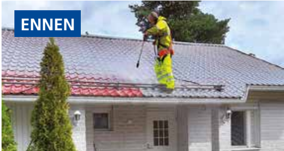
ENNEN Ehjä teräspeltikate vuodelta 1995. Uusittu pinta 2020. Suositus huoltomaalaukselle 2060.
