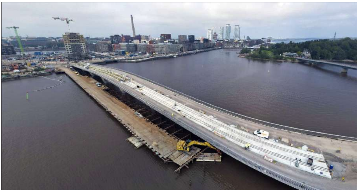
Kalasataman ja Korkeasaaren yhdistävällä Finkensillalla rakennetaan jo raitiotiekiskoja.
