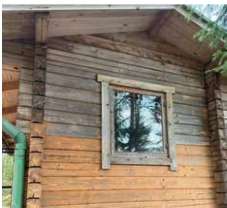
Hirsiseinien vanhojen maalien ja lakan poisto puhaltamalla
