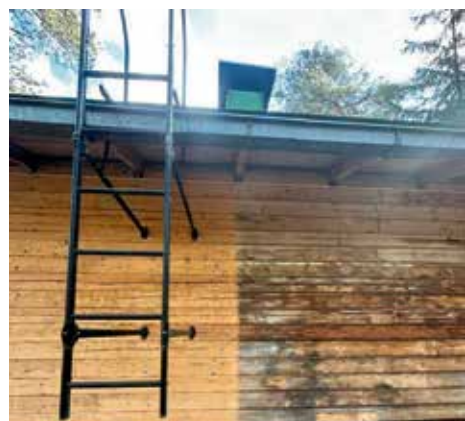
Hirsiseinien vanhojen maalien ja lakan poisto puhaltamalla
