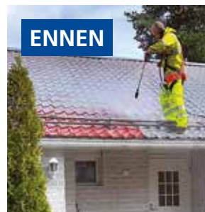
Enhä teräspeltikate vuodelta 1995. Uusittu pinta 2020.
