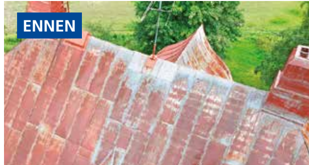
Peltikatto vuodelta 1926. Huoltomaalaus tehty 2020. Suositus huoltomaalaukselle 2060.
