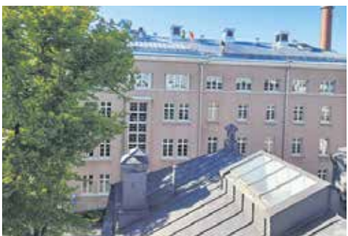
Tyks: hallintorakennuksen peltikaton maalaus.
