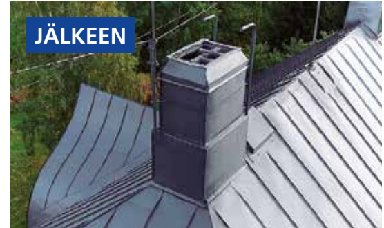
Peltikatto vuodelta 1926. Huoltomaalaus tehty 2020. Suositus huoltomaalaukselle 2060.
