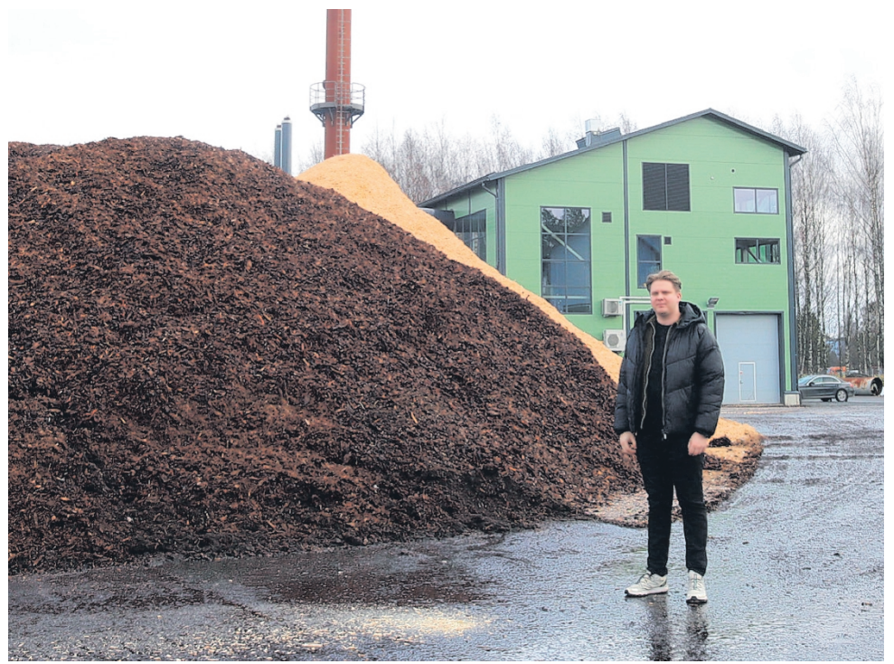
Alajärven Lämpö Oy:n toimitusjohtaja Matti Etula taustalla hakkeesta ja kuoresta muodostuva polttoainevarasto. Niillä tuotetaan suurin osa Alajärven kaukolämmöstä.
