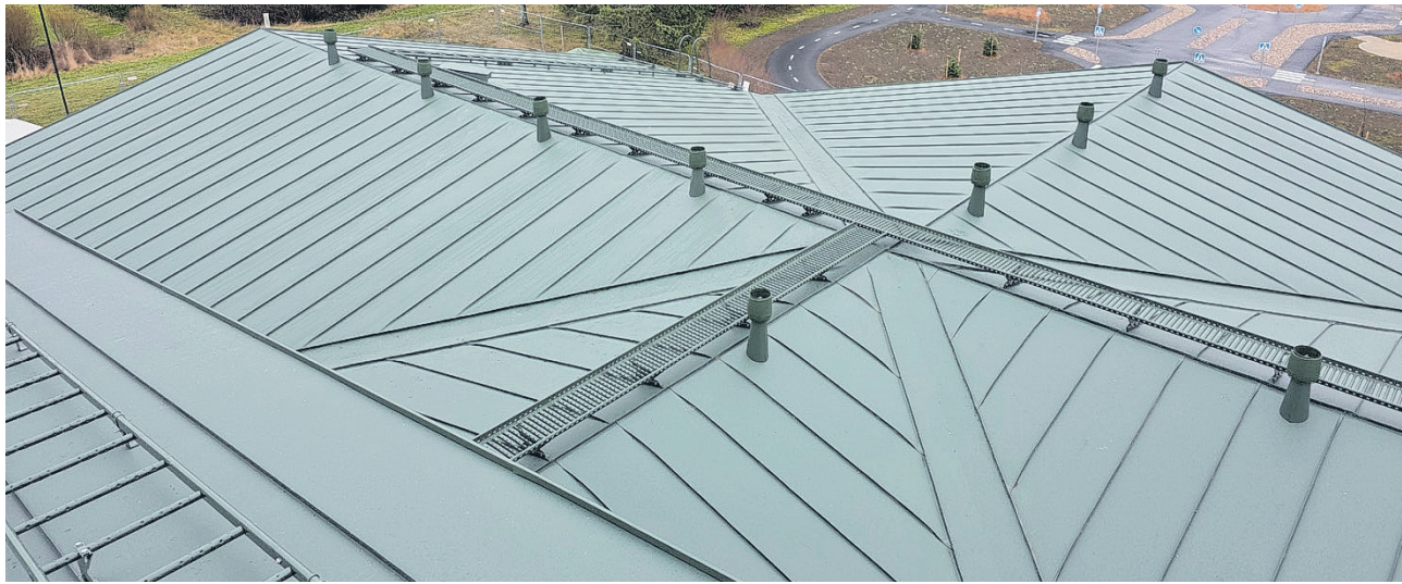
Konesaumakaton erityispiirre on se, että pellit liitetään toisiinsa kaksinkertaisella saumauksella, jolloin katosta tulee täysin tiivis. Osa Peltisepäniike Arto Turjan toteuttamista kohteista on ollut kooltaan varsin mittavia.
