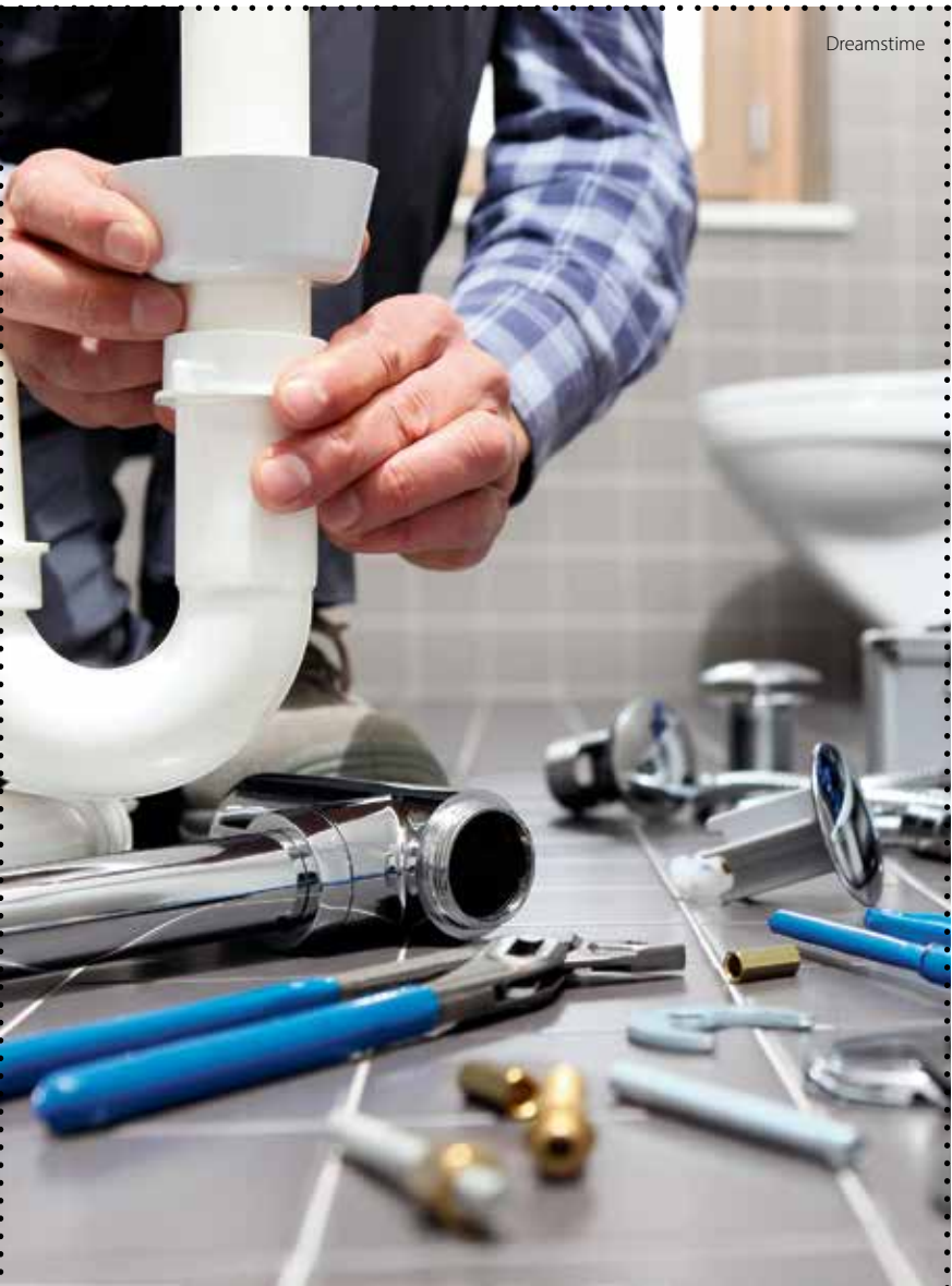
Vesi- ja viemäriputkistot ovat yksi tavallisimmista kuntotutkimuksen kohteista taloyhtiössä.
