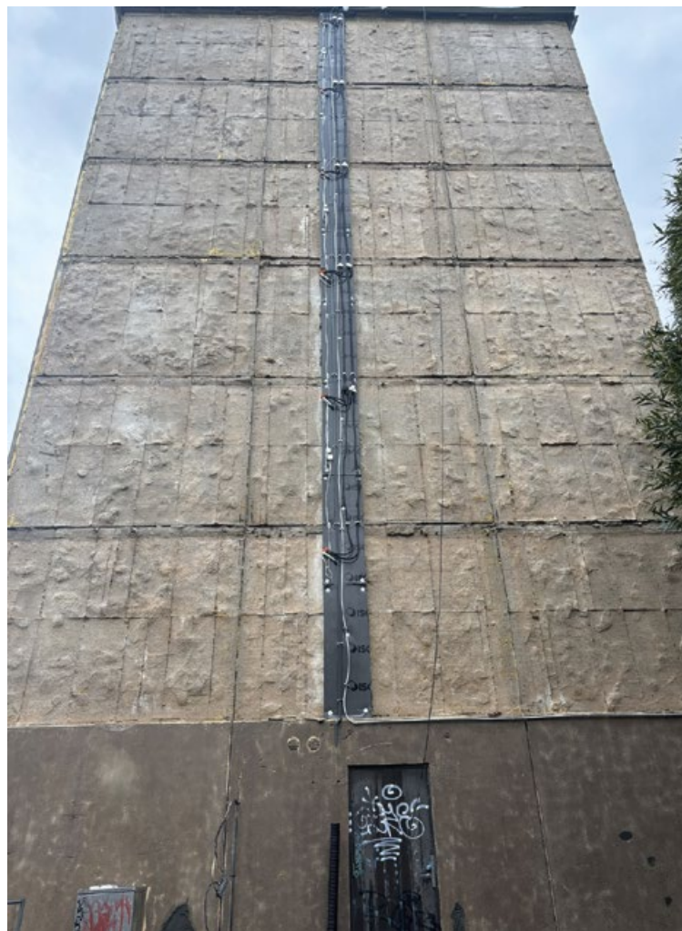
🔍 Kylmäaineputket ja kondenssiveden poistot saatiin kulkemaan julkisivulevyjen alla. Kuvassa levyt asentamatta.
