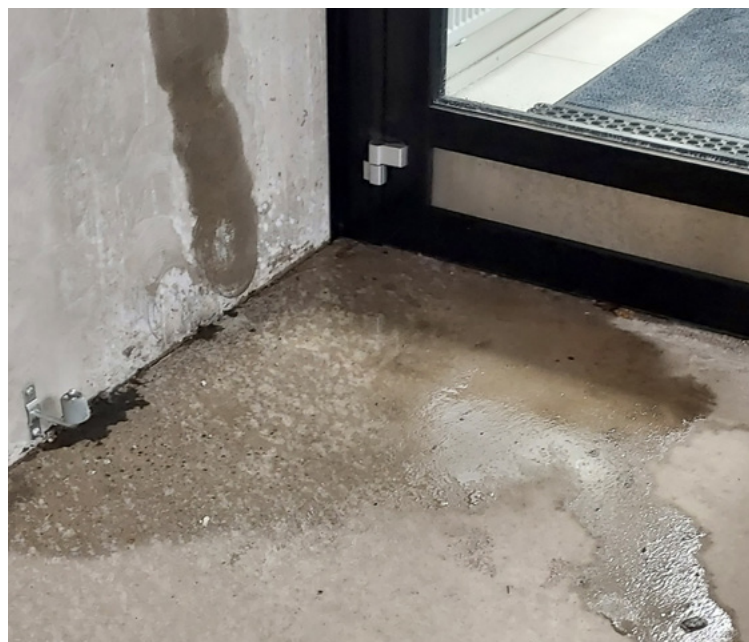
Autohalliin valuu sateella vettä, jota päätyy märkien kenkien mukana myös rappukäytävän puolelle. Kuva: Harri Holtari
