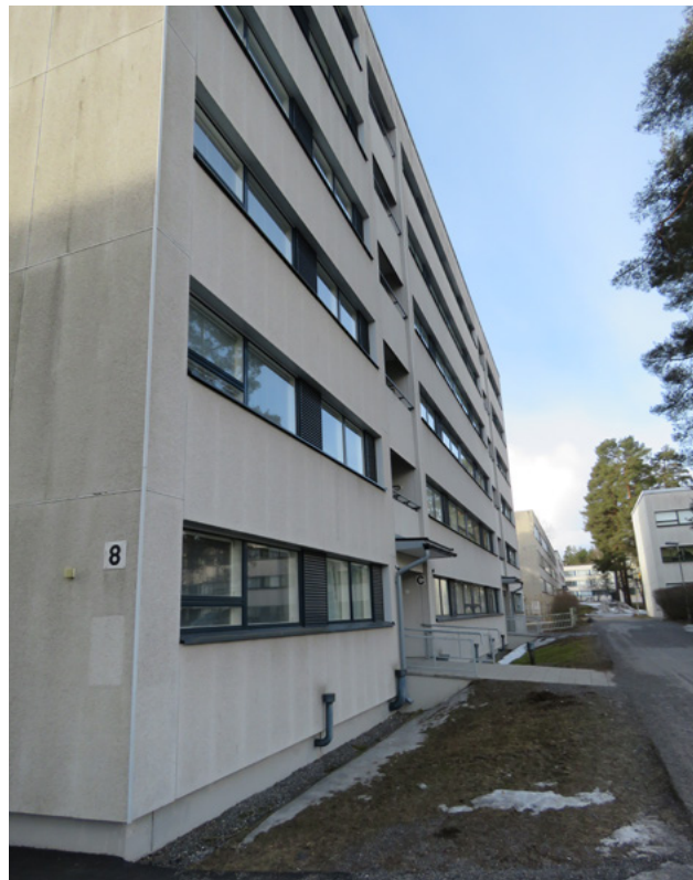
As Oy Tuuvanhovissa Turun Runosmäessä esteetön sisäänkäynti toteutettiin muuttamalla ensimmäisen kerroksen tuuletusparvekkeet sisäänkäynneiksi. Luiskat saatiin tehtyä hyvin pienellä nousulla.
