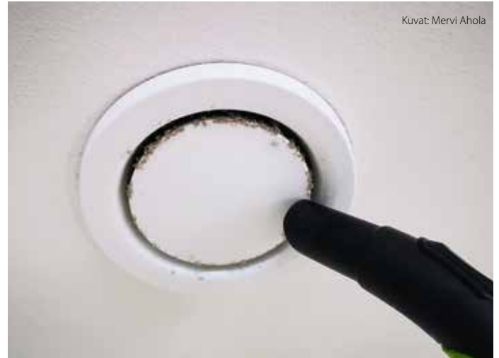
Poistoventtiilin imurointi.
