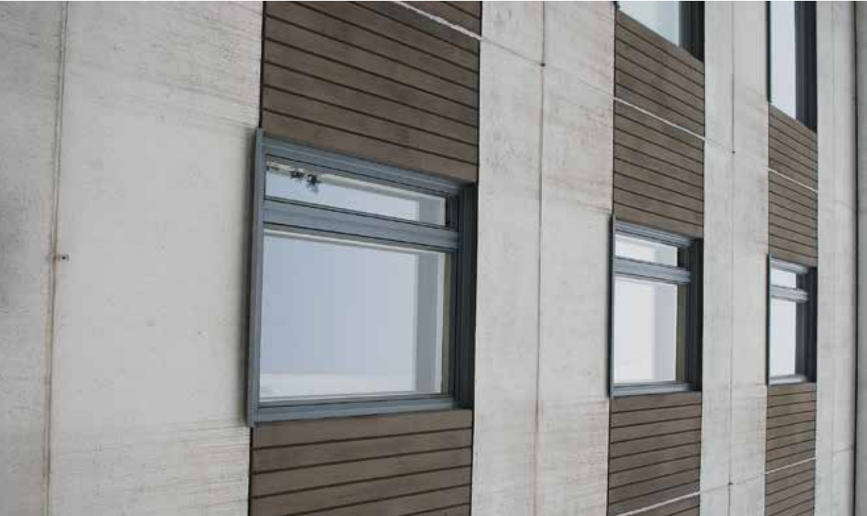
Elementtitaloja nousi erityisen runsaasti 60-70-luvuilla paikkaamaan silloista asuntopulaa. Niissä heikko kohta ovat elementtien välisen saumat, joita on tarkkailtava säännöllisesti ja uusittava tarpeen mukaan.
