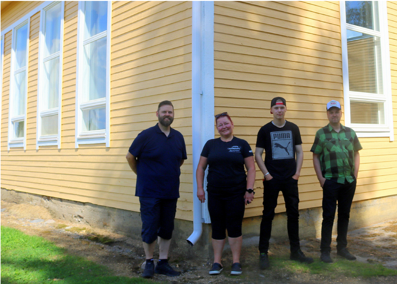
Kimmo Mäkelä, Saija Ylinen, Mikko Matintupa ja Olli Kantola iloitsevat siitä, että yksi projekti Hoiskon Maamiesseuran talolla on nyt ohitse, kun Aisaparin avustuksella ulkoseinäremontti saatiin valmiiksi. Seuraavaksi jatketaan katon kunnostukseen.
