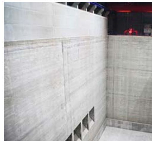
Jäteautot kippaavat jätteen 38 metriä syvään betonibunkkeriin.
