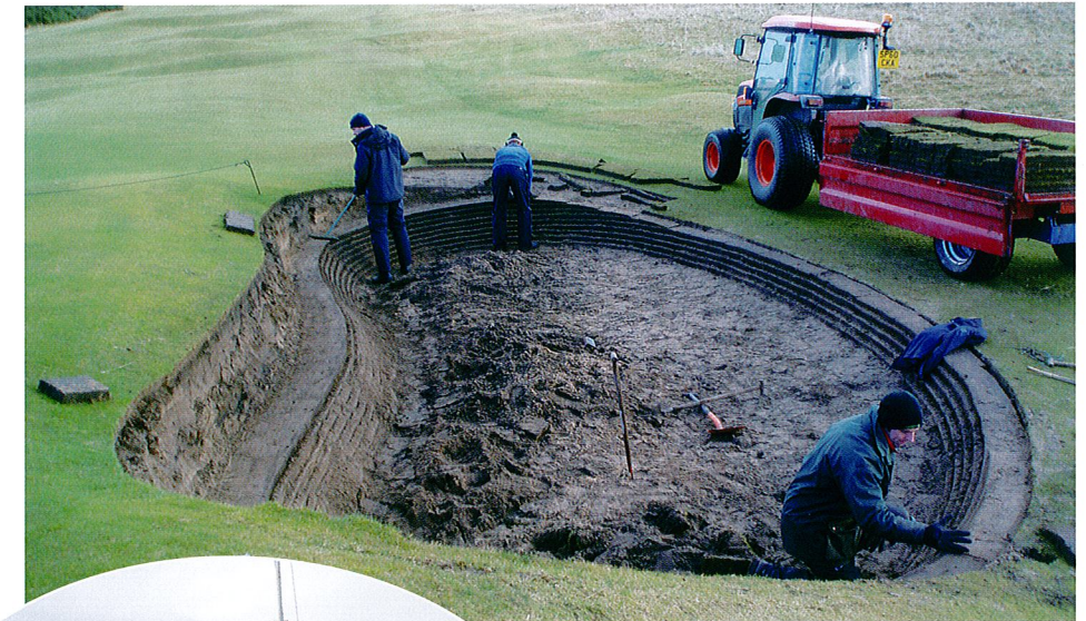
Dornochissa Jari muun muassa rakensi hiekkasteen rivettireunaa. (yllä)
