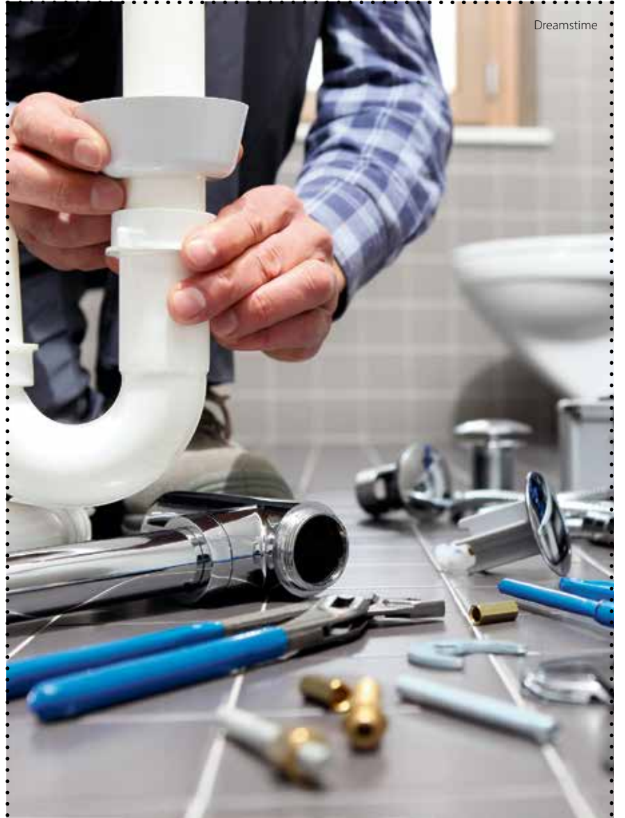
Vesi- ja viemäriputkistot ovat yksi tavallisimmista kuntotutkimuksen kohteista taloyhtiössä.
